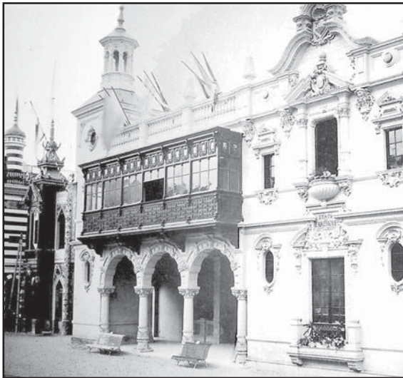
Fachada del pabellón de América Central y Meridional. Rue des Nations. ©Wordfairs Forum, 2019.
